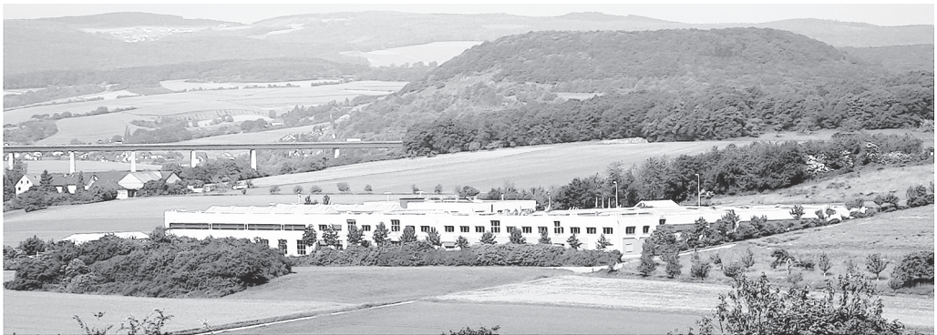
Gesamtansicht des Werkes HEUFT SYSTEMTECHNIK am Burgbrohler Herchenberg
