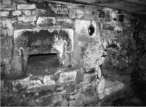
Am Backofen fehlt nur die eiserne Tür zum Verschließen.
