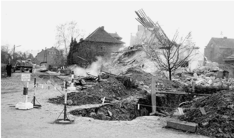
Abriss Haus Schirmbeck für die neue B9, 1965
