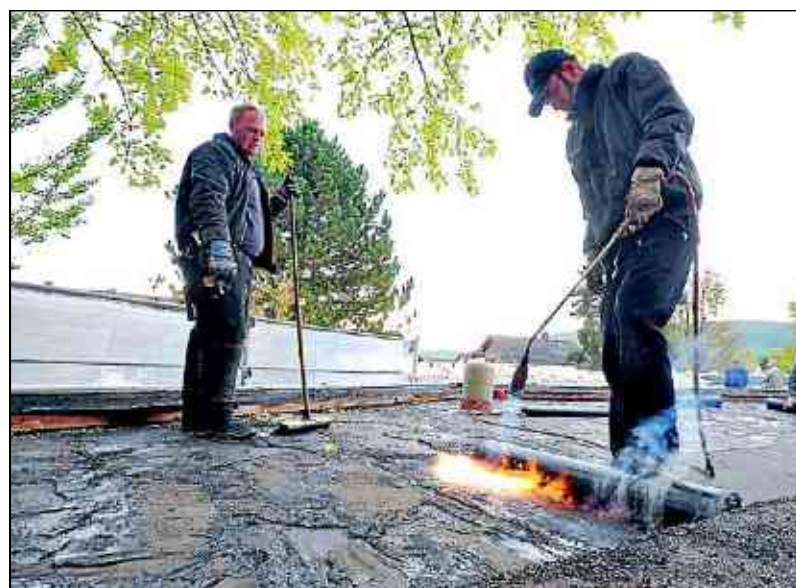
Für rund 350 000 Euro wird das Dach der Kindertagesstätte wieder abgedichtet und saniert. FOTO: MARTIN GAUSMANN
